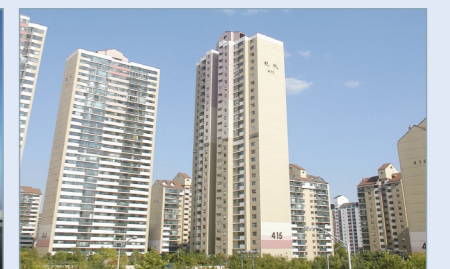
건축물의 단열 (아파트, 주택)
