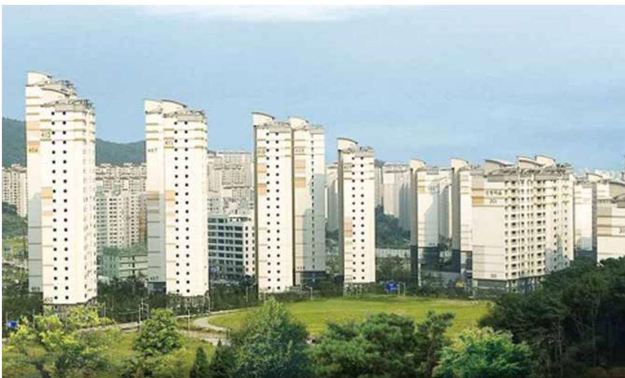
➤ 용인신봉 동일하이빌아파트 현장
